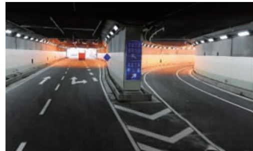
图 16 武汉长江隧道武昌端出口 (图片来源: 新华社) Fig. 16 Wuchang exit of Wuhan Yangtze River Highway Tunnel
