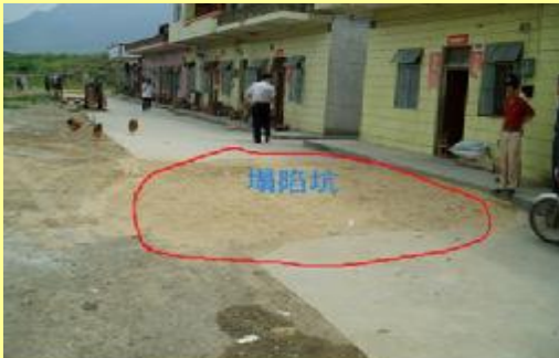
照片1 本次地面塌陷现场（调查时塌陷坑已填埋）
