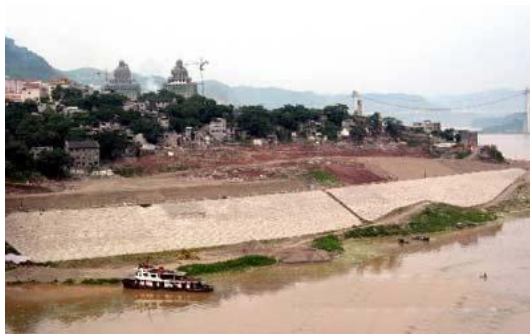
重庆市万州区和平广场滑坡治理工程
