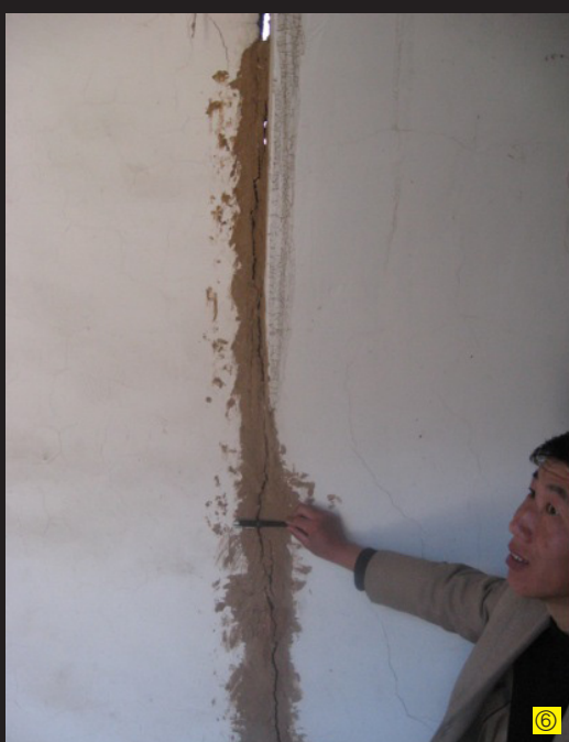
图1: 房屋变形, 墙壁外裂形成巨大缝隙 图2: 窑洞扭曲变形, 处在跨塌的边缘, 已经无法居住 图3: 房屋围墙因开裂而成的缝隙 图4: 房屋墙壁内侧出现裂缝 图5: 屋内地面开裂 图6: 居民用泥巴糊住房屋裂缝 图7: 滑坡造成的山顶上出现巨大裂缝 图8: 滑坡造成的山顶上出现巨大裂缝, 并伴有明显沉降, 左右两盘落差达30厘米
